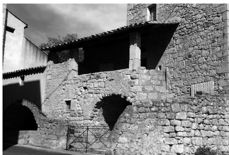
Maison ancienne, volumes simples et fonctionnels : terrasse protectrice, voûte de pierre porteuse
