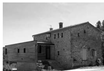
L'extension contemporaine permet de créer une pièce de séjour largement ouverte sur le paysage côté sud. Ce projet conserve ainsi le bâtiment d'origine en l'état et contribue à la mise en valeur d'un élément patrimonial existant. Atelier 3A, architectes.
